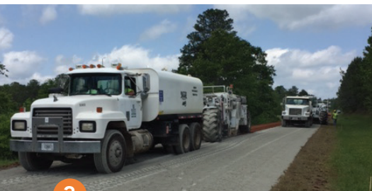
3 FDR reclaimers commence
